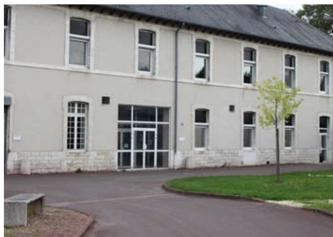
Bâtiment pharmacie - site de Bourges
